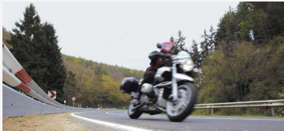
Der Unterfahrerschutz an Leitschranken gehört zu den passiven Massnahmen. Seine Existenz kann optische und damit psychische Sicherheit vermitteln. (Fotos U. Grützener)
